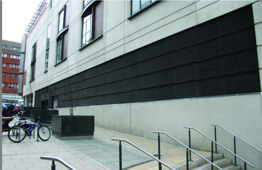
The Light, Leeds. Single bank 1UL louvre v novější verzi 3UL pro více estetický vzhled.
